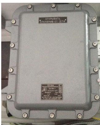
Рисунок 3 - Схема пломбирования крышки коробки взрывозащищенной КВ-КВЗ-3, в которой размещен клеммный блок для юстировки устройства отсчетного Топаз
